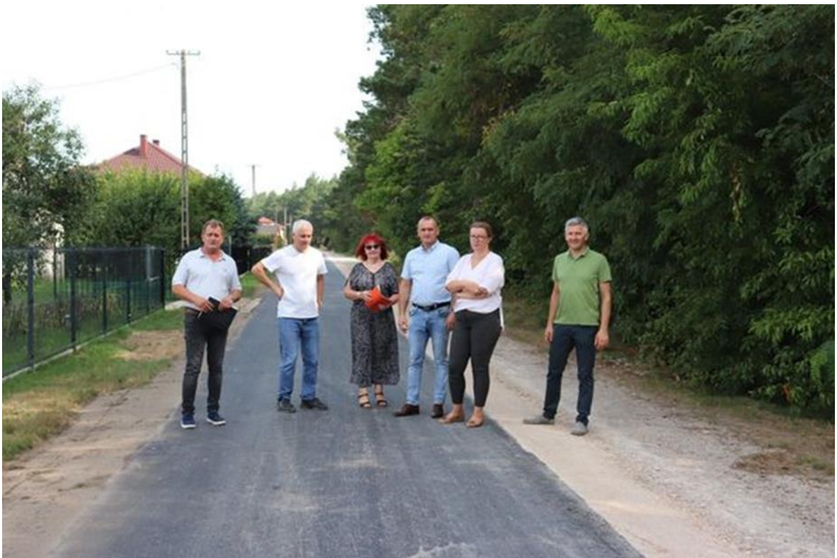
Przebudowa drogi dojazdowej do pól Dęba
