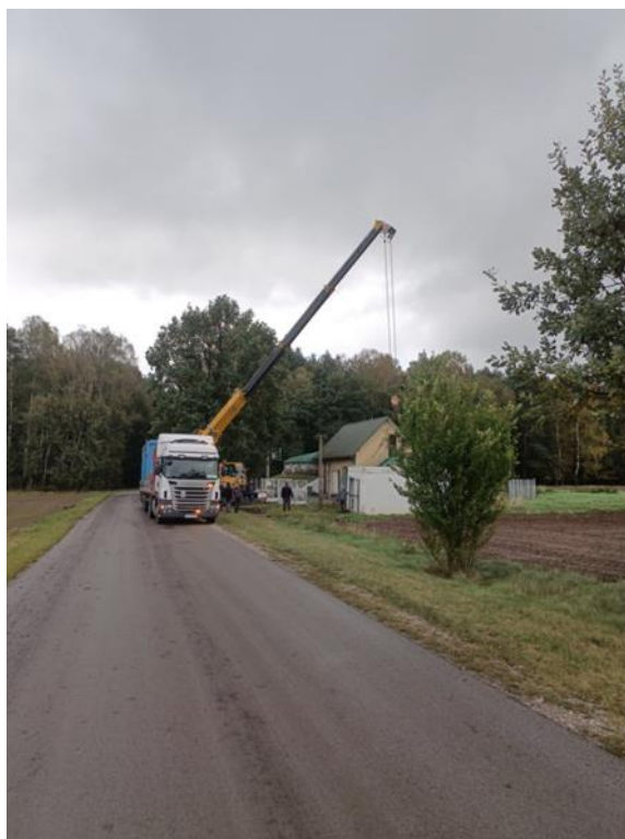
Rozpoczęcie prac „Modernizacja Biologicznej Oczyszczalni Ścieków”
