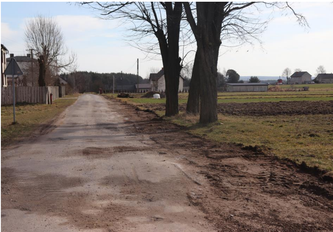
Przebudowa dróg gminnych
